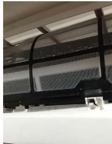
上図のようにエアコンのプラスチックの表カバーを開き、フィルターの下を外して上に持ち上げて、その間にエアエコ®を曲げて差し入れます。フィルターの奥側になります。
