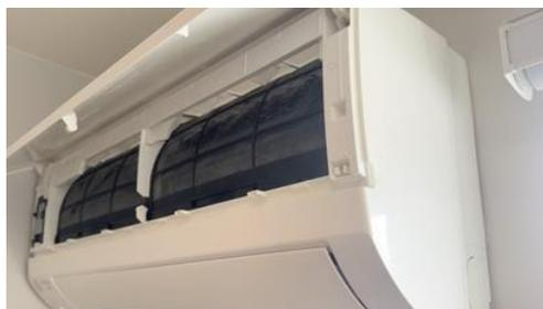
① エアコンのカバーを外します。破損等にお気を付け下さい。エアコンの種類により開け方は異なります。
